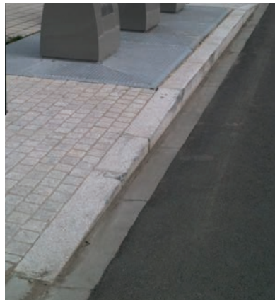
Bordure type «bateau» parallèle à la voirie Quai de bus devant les écoles
