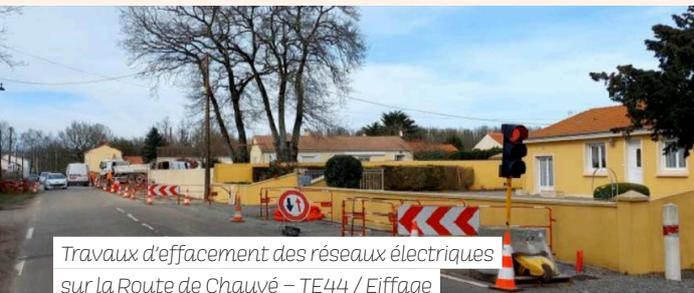
Travaux d'effacement des réseaux électriques sur la Route de Chauvé – TE44 / Eiffage
